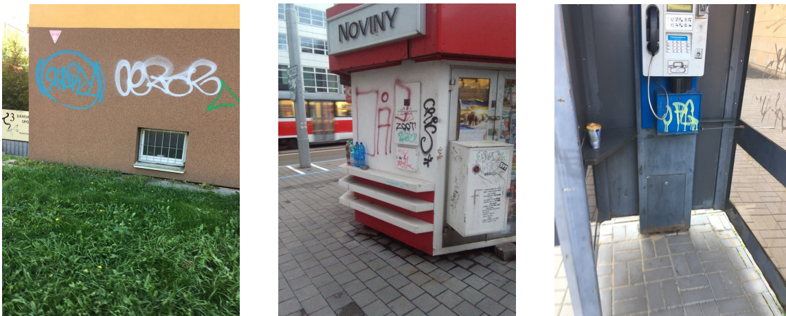
Obrázek 2.1: Vandaly poškozené objekty
