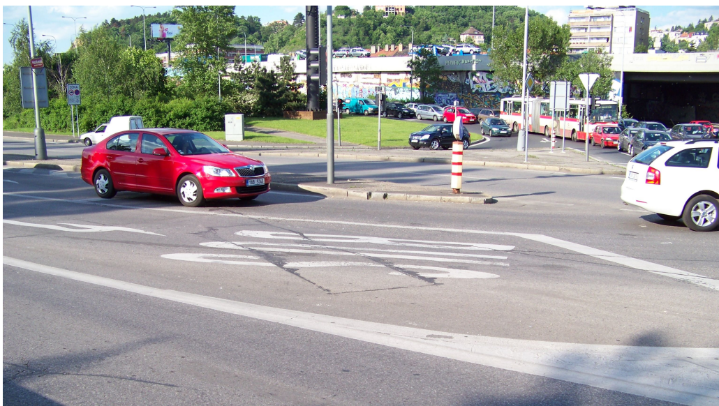
Obrázek 2.2: Detekční smyčka na pražské křižovatce v podobě černého obdélníku přes nápis „BUS“ (převzato z [15]).
